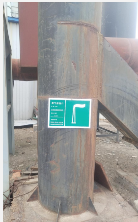
排放口标识牌
