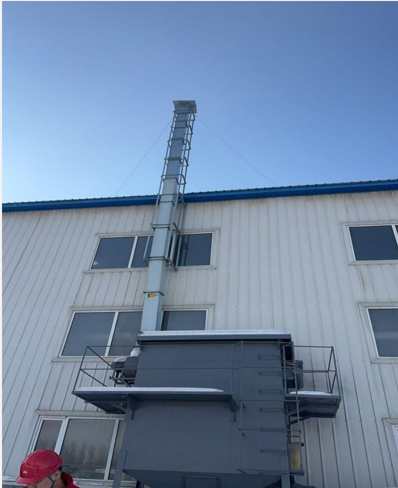
喷焊工序 15 米高排气筒
