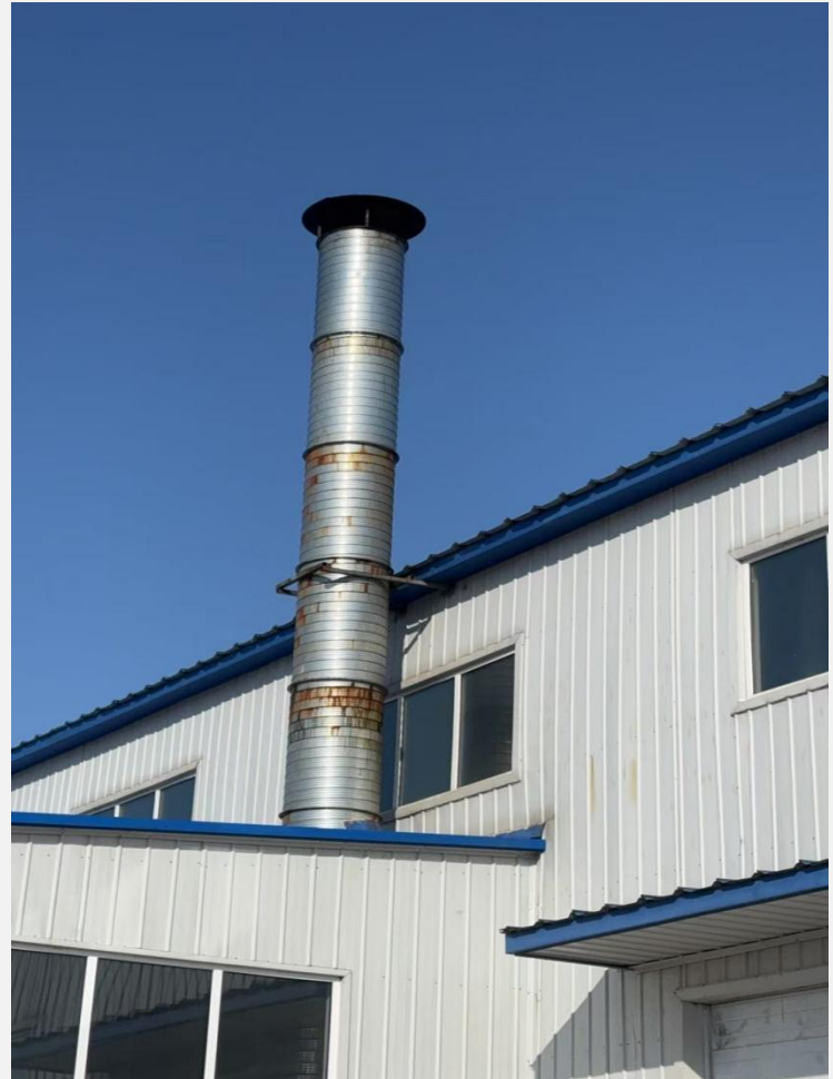
油管修复车间碳化工序 15 米高排气筒
