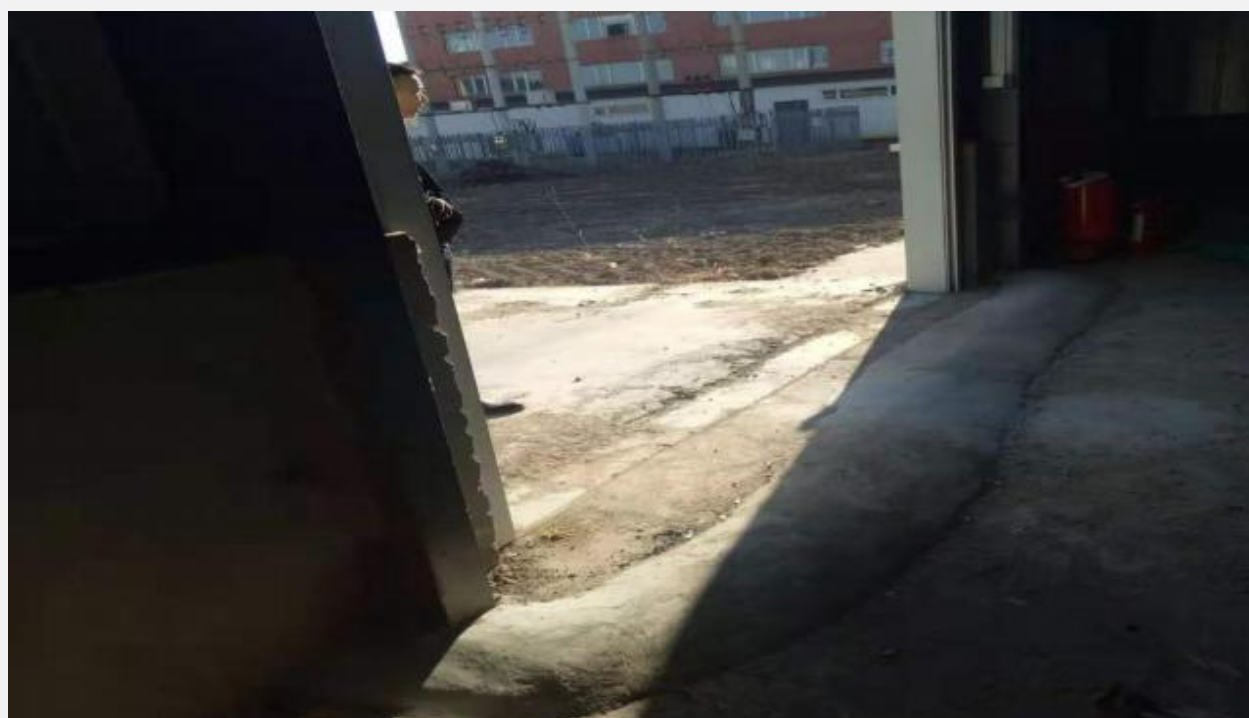
危险废物贮存库围堰
