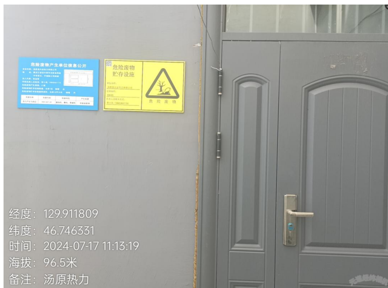
厂区现有危废贮存库现状
