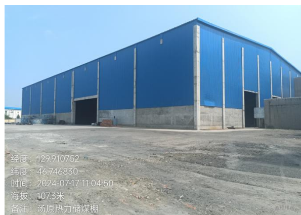
现有工程储煤库现状（2024.7）
