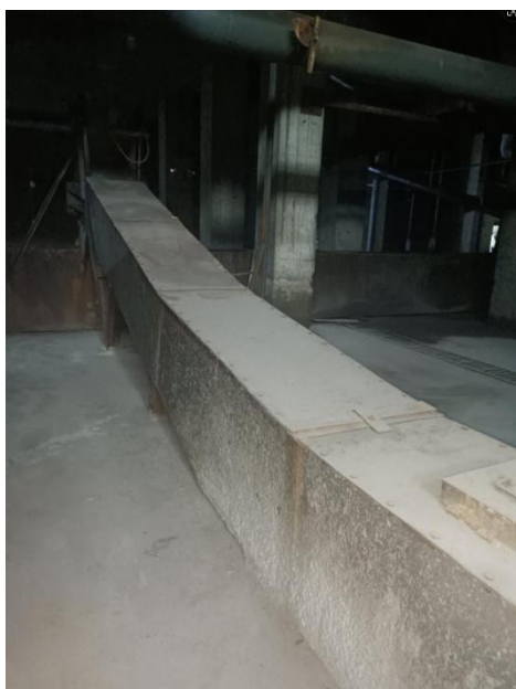
除渣系统封闭（2024.7）
