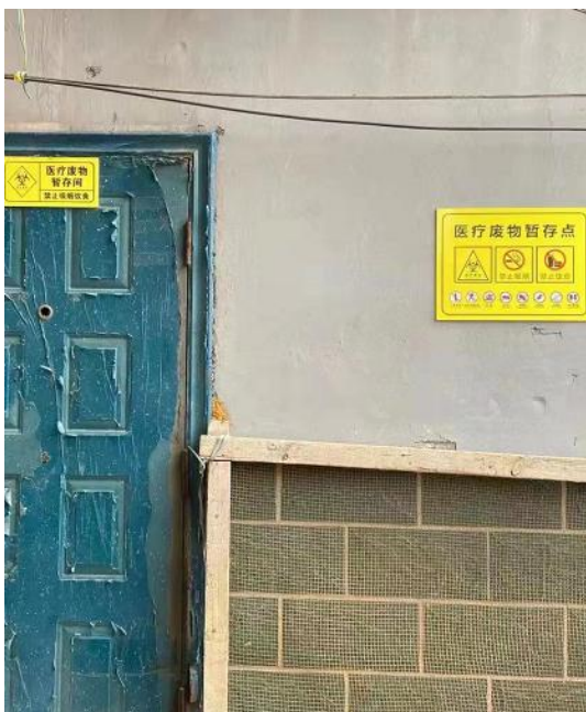
医疗废物暂存间
